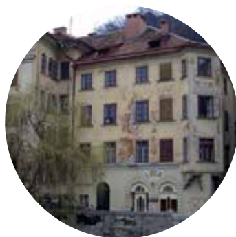
Primjer objekta prije obnavljanja
