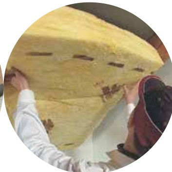
Slika 5: Izolaciju postavite između rogova - grede.
