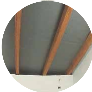
Slika 2: Prethodno položena paropropusna folija - sekundarni krovni pokrov
