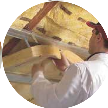
Slika 6: Ispod metalnog C-profila postavite drugi sloj izolacije.
