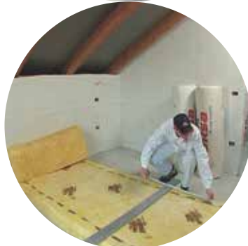
Slika 4: Izolaciju razrežite na ploče odgovarajućih dimenzija.
