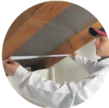
Slika 3: Dimenziji dodajte 1 do 2 cm više od izmjerene širine svijetlog otvora među rogovima - gredama
