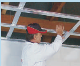
1 Postavimo metalnu konstrukciju
