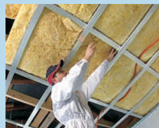
2 Postavimo prvi sloj izolacije
