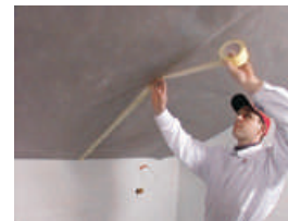
8 Svi spojevi, proboji i priključci na foliju moraju biti zalijepljeni
