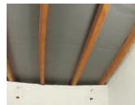
2 Položimo sekundarni pokrov paropropusnu - vodonepropusnu foliju
